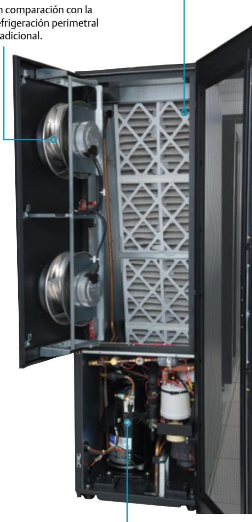
El **compresor con scroll digital** en los modelos compresurizados permite que la capacidad de enfriamiento variable corresponda de manera precisa con la demanda de refrigeración sin el ciclo de encendido y apagado. Como resultado se reduce el consumo energético y se extiende la vida útil del compresor.
